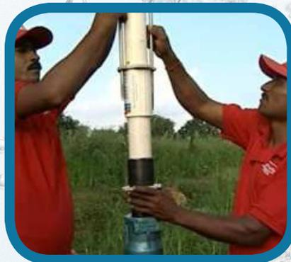
Fijación del guardamotor al adaptador inferior.
