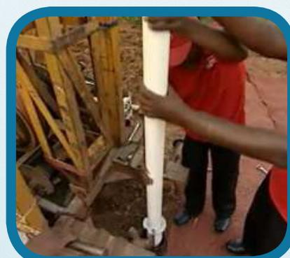
Introducir la bomba con el guardamotor y el primer tramo.
