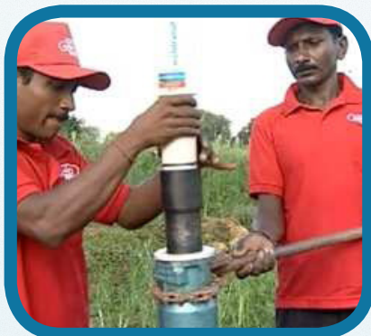
Roscar el primer tramo de tubería PYD.
