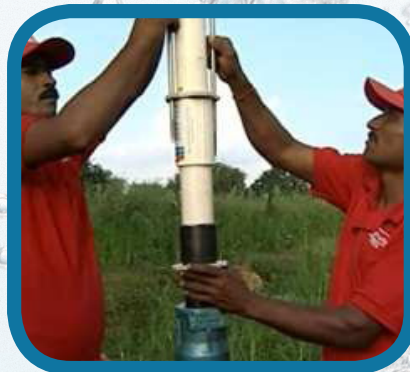
Fijación del guardamotor al adaptador inferior.
