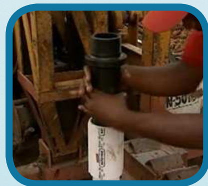
Finalizar roscando el adaptador superior.
