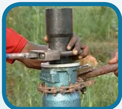
Roscar adaptador inferior a la salida de la bomba.
