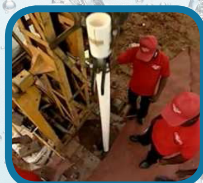
Descender la bomba roscando los tramos de tubería.
