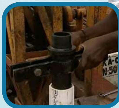
Fijar el sistema de suspensión y dejar descansar en el pozo.
